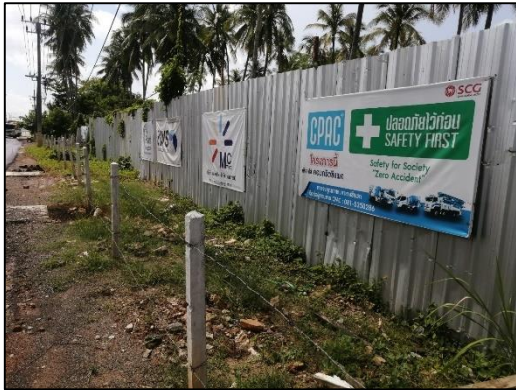
ภาพที่ 1 รั้ว Metal Sheet สูง 2.4 เมตร
